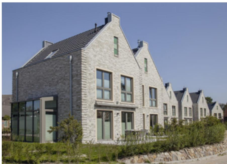
Spezielle Brennverfahren ermöglichen changierende Übergänge im Riemchen und erzeugen lebendige Flächen.
